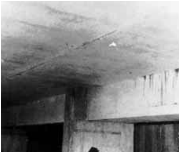
Universitaire fakulteiten St Aloysius te Brussel. Toepassing van PROMATECT®-H in verloren bekisting.
