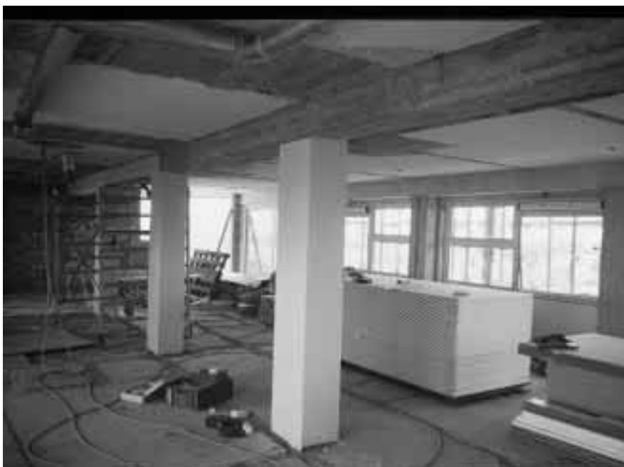
Universitaire fakulteiten St Aloysius te Brussel. Toepassing van PROMATECT®-H in verloren bekisting.
