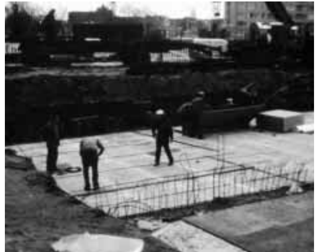
Verbindingstunnel E3 te Antwerpen. Toepassing van PROMATECT®-H in verloren bekisting.
