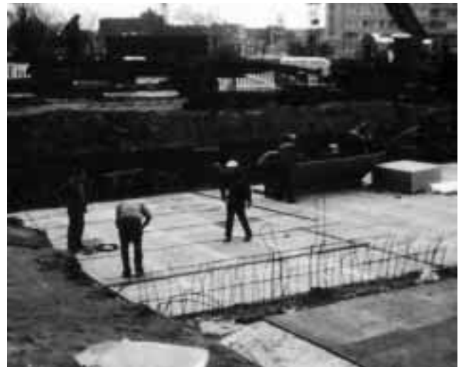
Tunnel de jonction E3 - Anvers. Application de PROMATECT®-H en coffrage perdu.
