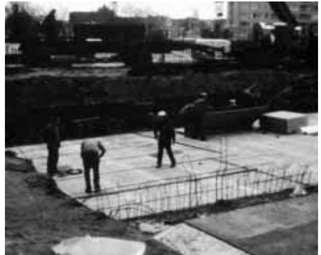
Verbindingstunnel E3 te Antwerpen. Toepassing van PROMATECT®-H in verloren bekisting.
