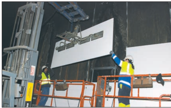
Manutention des panneaux PROMATECT®-H et GLASAL.
